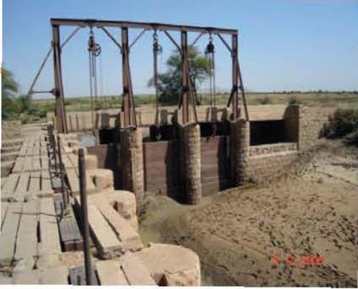
تراكم الطمي في المنشآت الهيدروليكية
